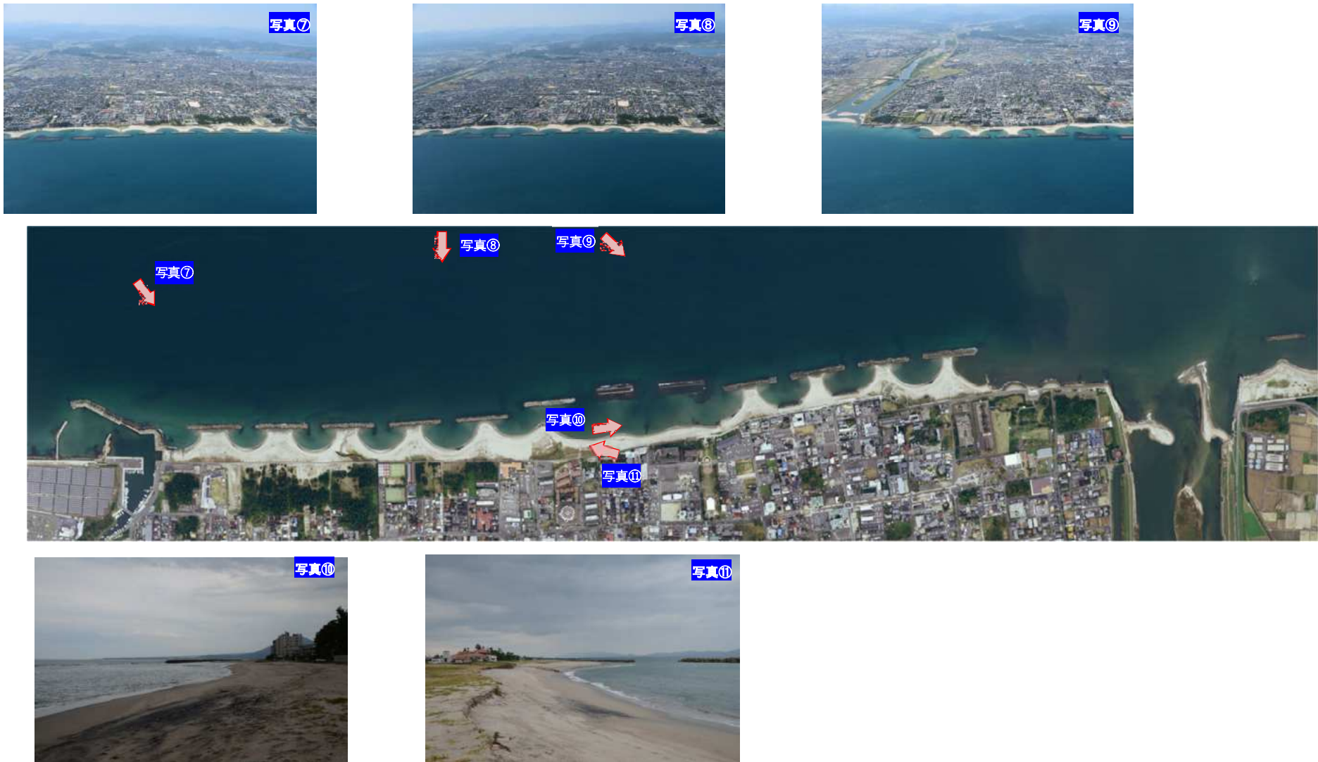
図 6.1.2 西部海岸の航空写真（2018年撮影）と現地写真（米子海岸（皆生工区）、2020年9月撮影）
