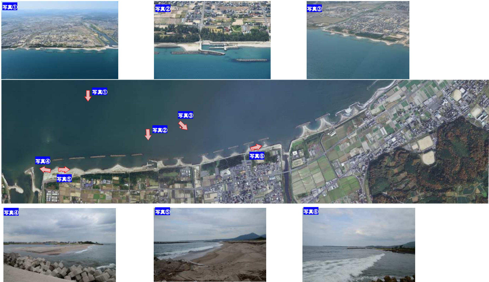
図 6.1.3 西部海岸の航空写真（2018 年撮影）と現地写真（日吉津海岸（日吉津工区）、2020 年 9 月撮影）
