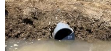
区画⑥ パイプのみ落水口
