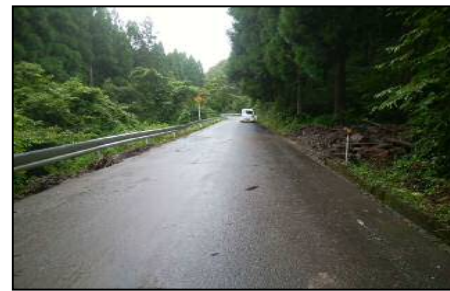
応急復旧工事完了後
