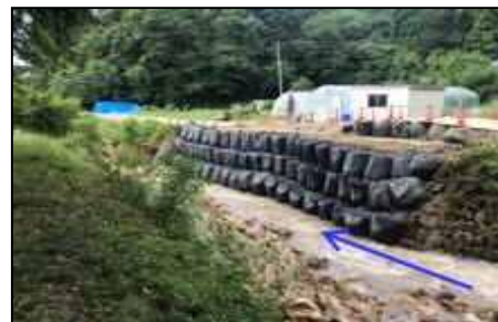
応急復旧工事完了後
