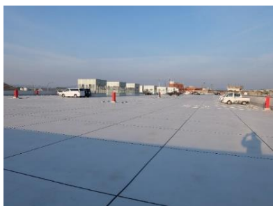
1号上屋の屋上駐車場 (見学者用に90台確保)
