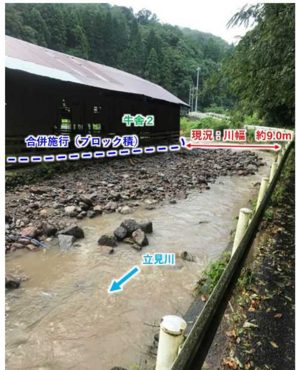
立見川(上流側を望む)
