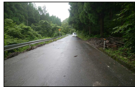
応急復旧工事完了後
