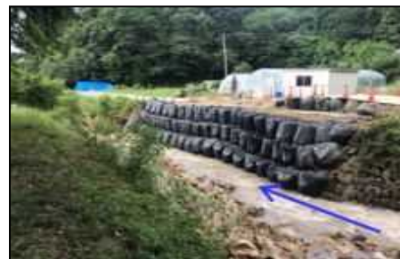
応急復旧工事完了後
