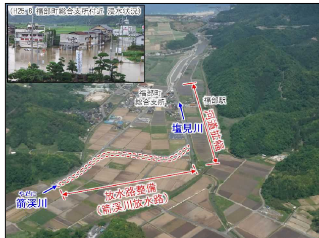
<河道拡幅・放水路整備：塩見川 (鳥取市福部町細川)>
