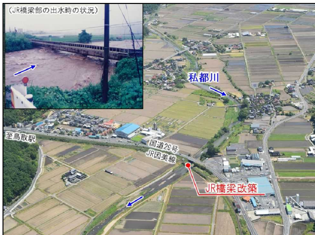
<JR 橋梁改築：私都川 (八頭町門尾)>
