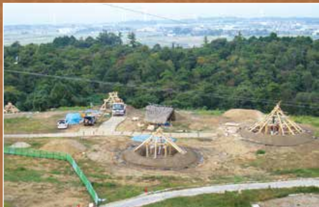
建設中の妻木山地区弥生のムラ（2010年）
