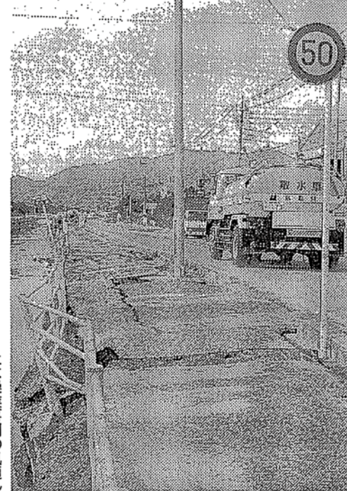
現在でも被害のつめ跡が残る竹内工業団地
