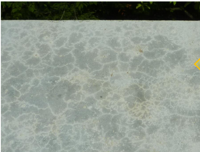
写真-4 表面の急激な乾燥によるひび割れの例
