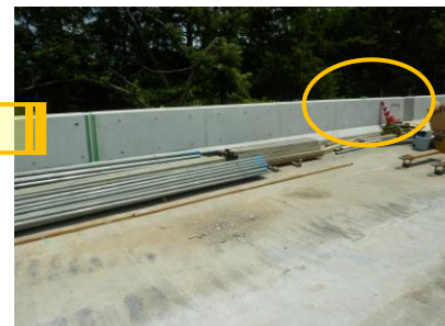
橋梁壁高欄の上面
