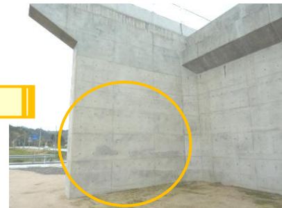
橋台の縦壁・翼壁背面
