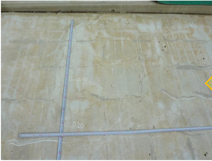
写真-2 沈みひび割れの例（上面鉄筋によるもの）
