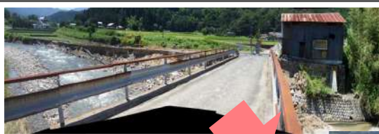
【智頭町木原橋付近】
