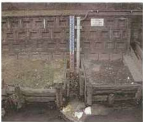
水位計設置状況
