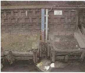
水位計設置状況
