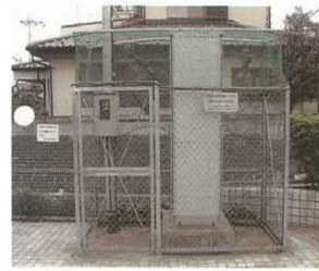
観測装置設置状況
