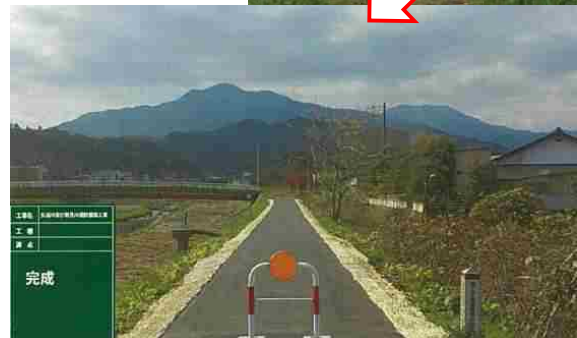
R2施工箇所：矢送川（倉吉市）等
