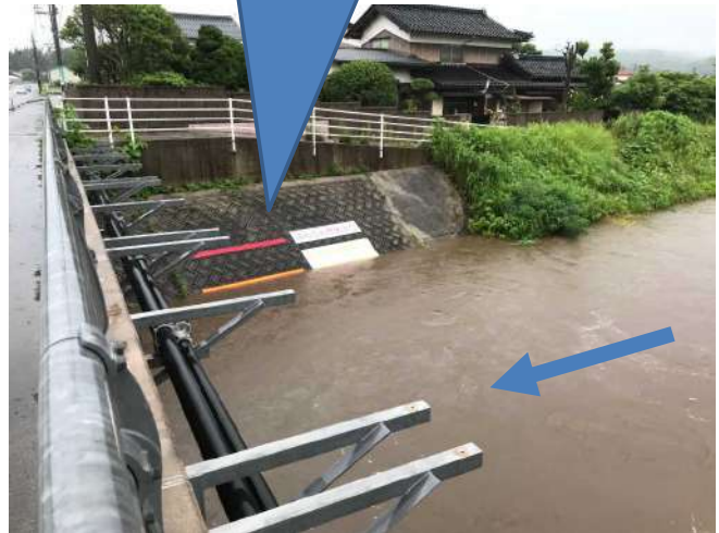
量水標により確認できる避難判断水位到達直前の状況 (天万橋上流 7月5日16時ごろ)
