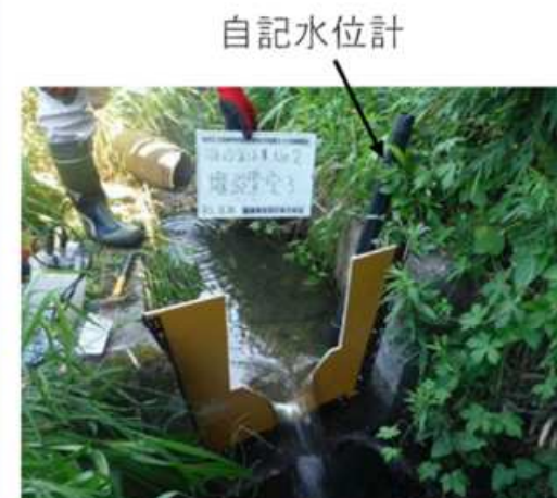
調査地点の状況 観測地点②(計画地下流)
