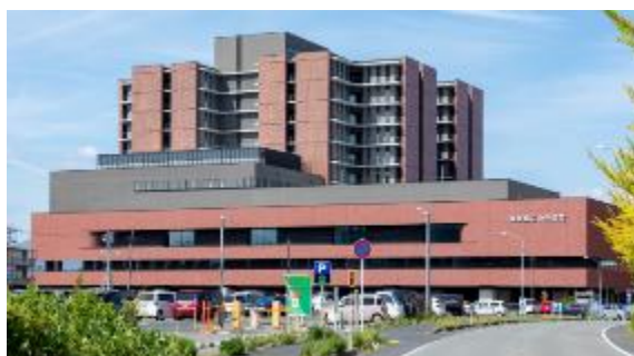
新病院の全景
