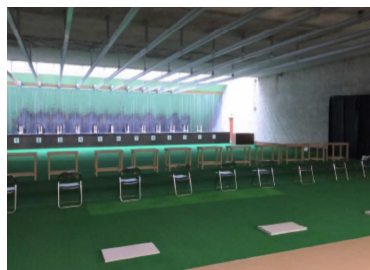
【射撃場内(石綿撤去前)】
