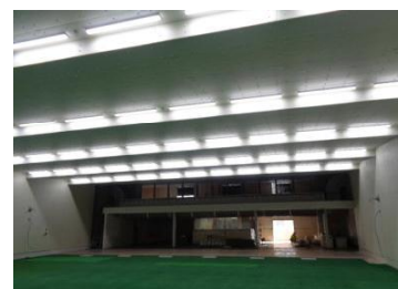
【石綿撤去後の状況】
