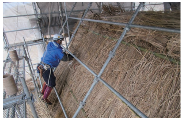
復元高床倉庫（MKSB219）屋根葺き替え作業
