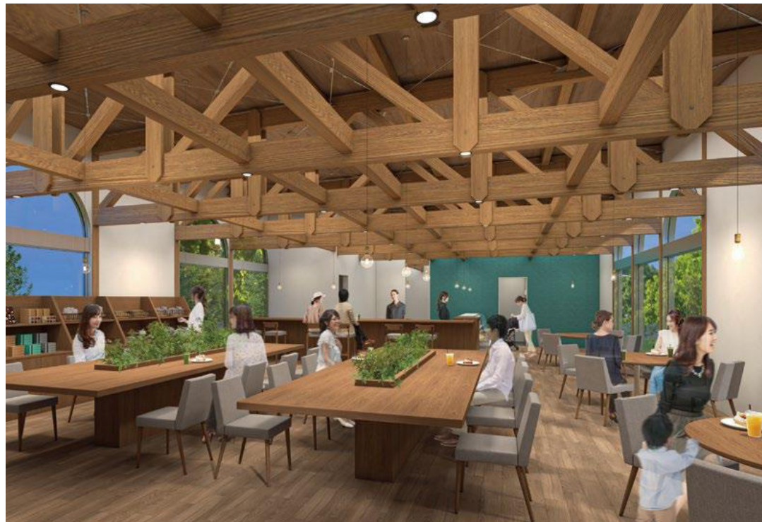
店舗の内観 9mの無柱空間は平行弦トラスを採用している
