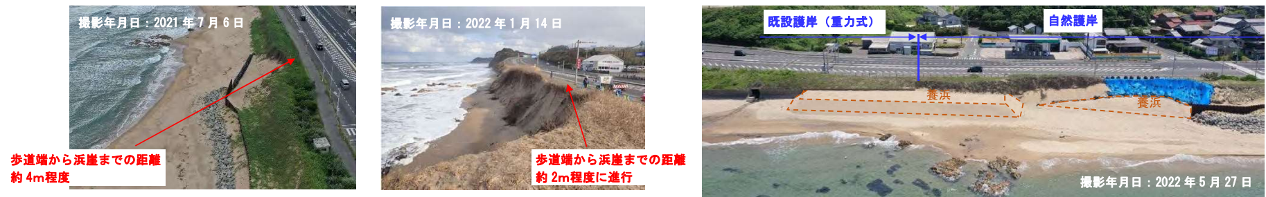
図 1-2 現地状況写真
