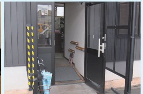
手すりとし社員お手製のスロープ
