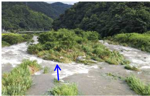
<天神川（三朝町曹源寺）>
