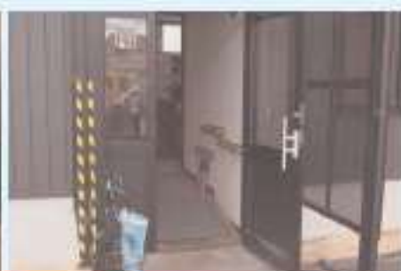
手すりと社員お手製のスロープ
