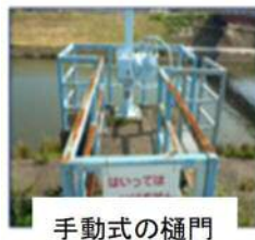
手動式の樋門
