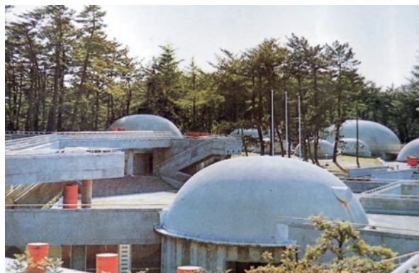
特殊な工法で建築されたコンクリートドーム。 現在は一棟のみ、トイレとして残されている
