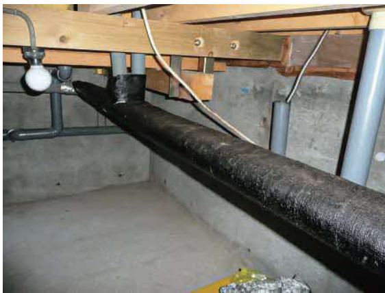
写真 2-4 床下に土間コンクリートが施工されている例(防湿層の役割を果たす)
