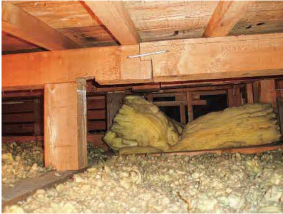
写真 2-6 小屋裏の断熱材の有無、及び劣化事象等の確認
