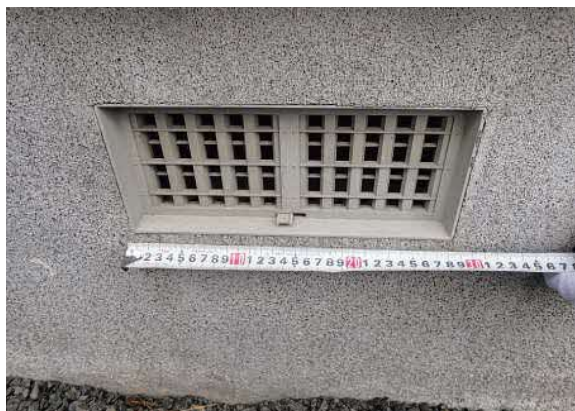
写真 2-1 基礎の床下換気口の設置状況の確認
