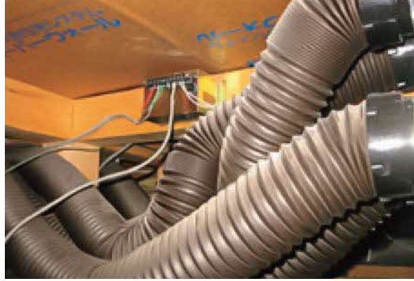
写真 2-8 小屋裏や床下にある換気ダクトの接続状況(脱落の有無)の確認
