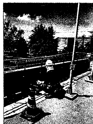
手すりの塗装
