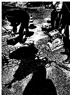
職員による修繕作業 (駐車場)
