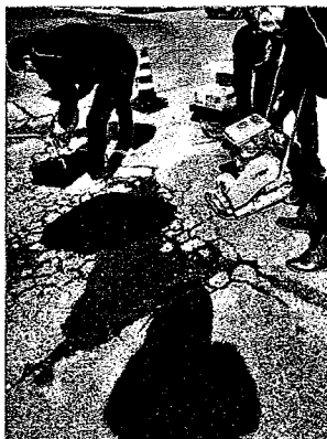
経費の削減（職員による修繕）
