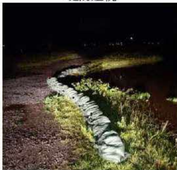
岩木川左岸（野木地先） 積み土のう工
