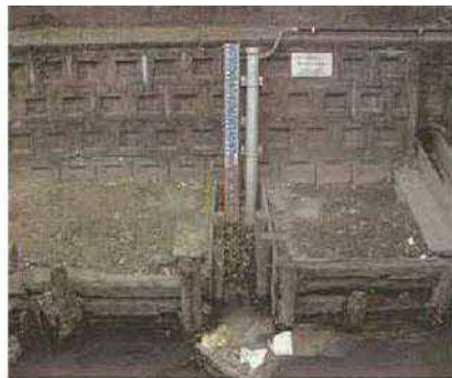
水位計設置状況
