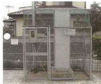
観測装置設置状況
