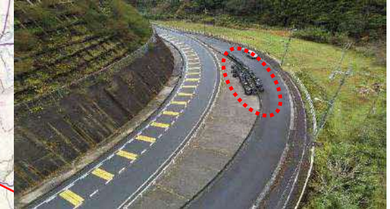
< 日野町管内対応用土のう仮置場 >
