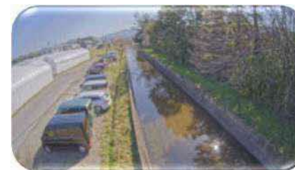
④箕蚊屋排水路王子製紙北側
