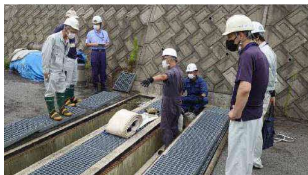
排水管接続訓練 (南部町境)
