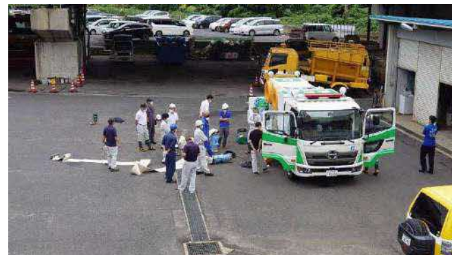
排水管接続訓練 (西部総合事務所)
