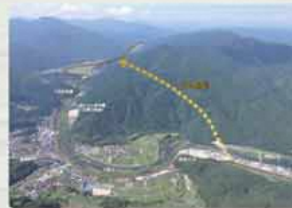
江府道路(久連トンネル)整備
