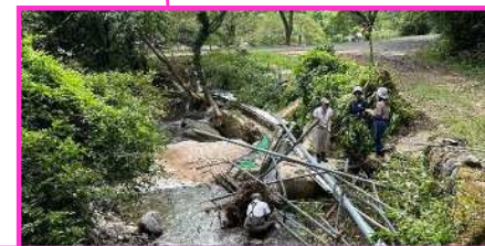
養魚場取水パイプの流出 (八頭町福地(やずちょうふくち))
