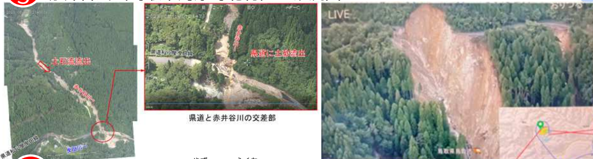
6 県道麻生国府線（八頭町福地）の道路崩落
