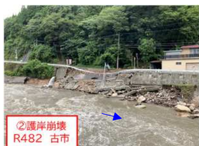
7 国道482号（鳥取市用瀬町別府～佐治町栃原）の道路崩落、土砂流出
