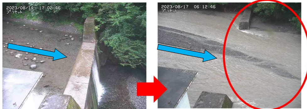
台風7号の出水で土砂が堆積(佐治川ダム上流砂防ダム監視カメラ)
