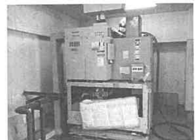
エレベーターオイル交換作業
