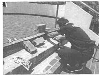
階段タイルの修繕
