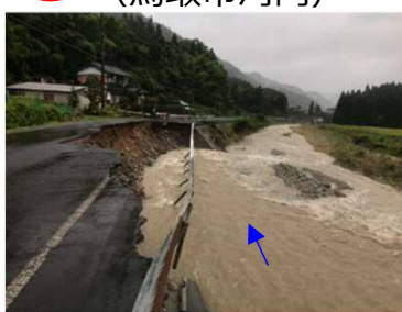
3 県道河内楨原線（鳥取市河内）
