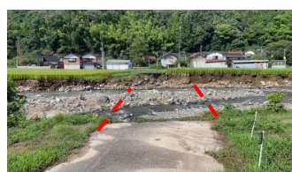
流出した農道橋 (八頭町麻生)
