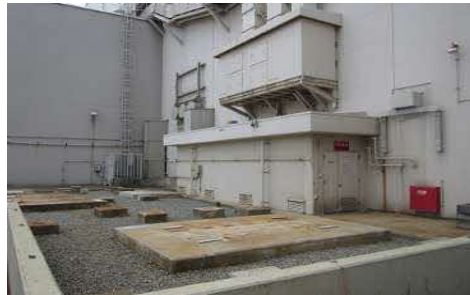
撤去作業後の状況
