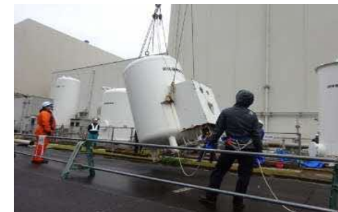
撤去作業の状況
