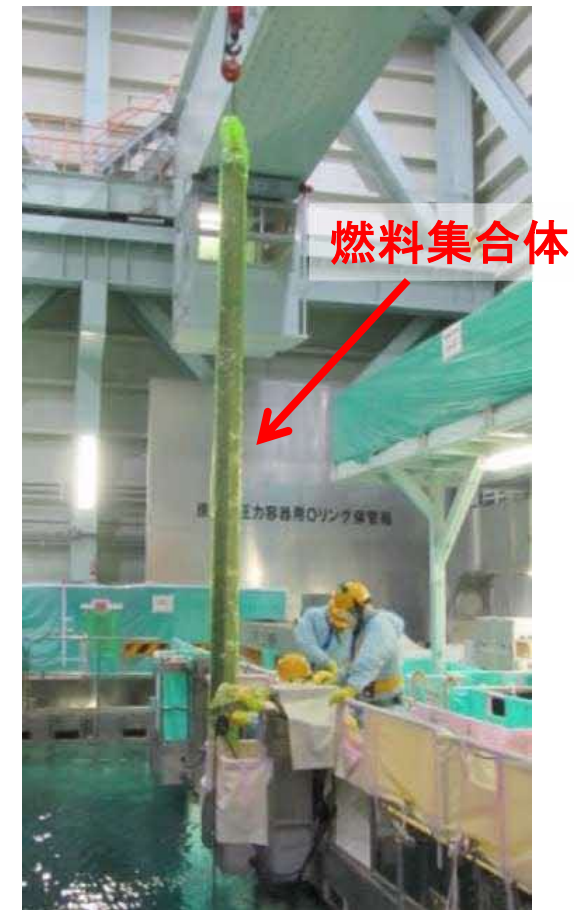
新燃料の引き上げ状況
