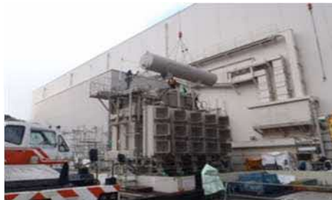
撤去作業の状況
