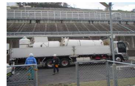
解体物の移送
