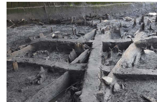
木製の土留め（北から）
