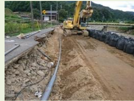
＜八頭町福地＞ 道路復旧にあわせて埋 設工事
