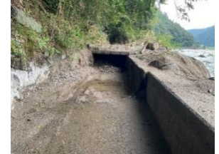
排土による通水確保 (R5.9.24完了)
