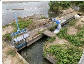
※排土工事中は代 替えポンプを稼働 R5.9.6撮影)
