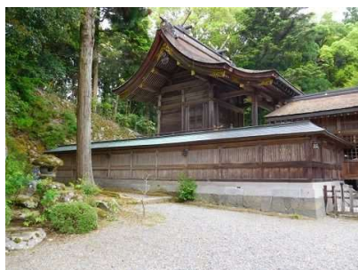
本殿及び透塀
