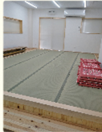
改修後の休憩室
