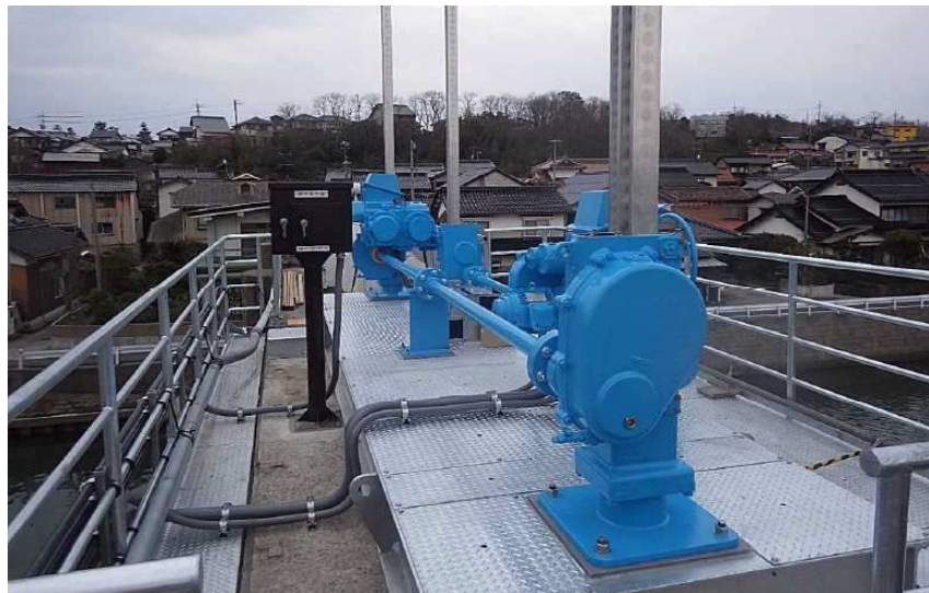
開閉装置 (逆流ゲート中央部)
