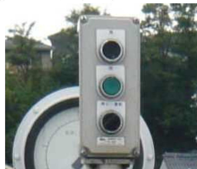
機側操作盤(上:開釦、中:閉釦、下:停止スイッチ)
