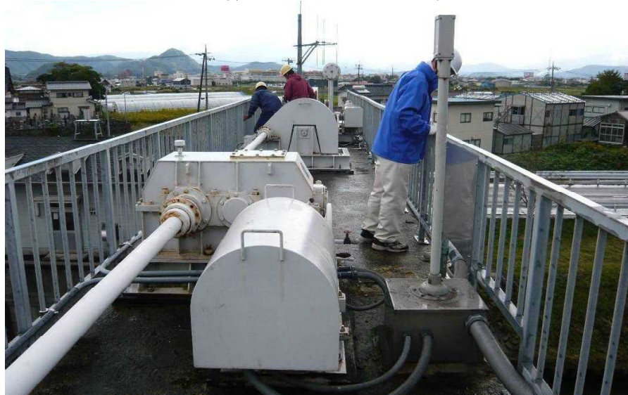
開閉装置 (逆流ゲート中央部)
