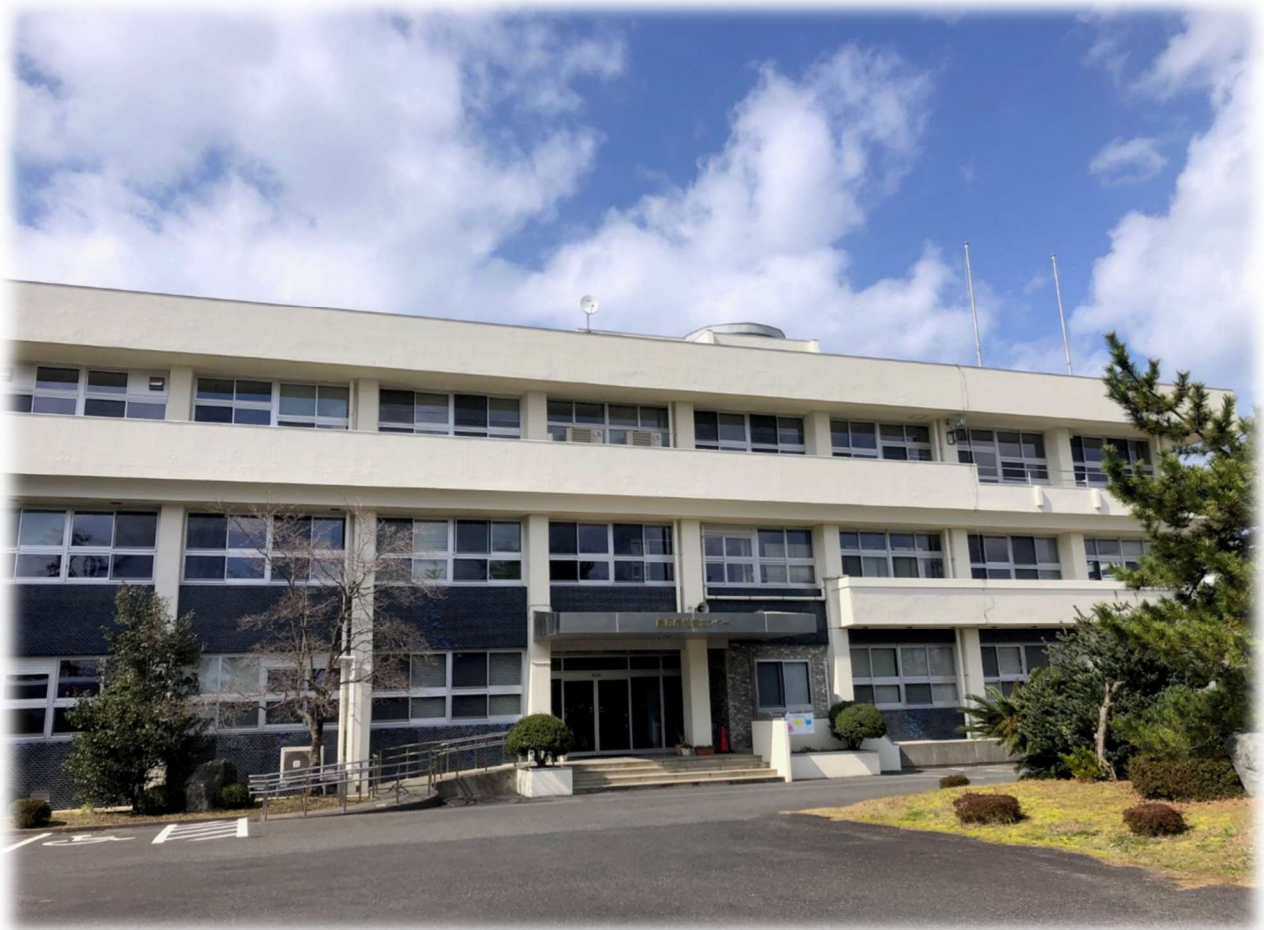
外壁改修工事を行って新しくなった外観（令和6年3月撮影）
