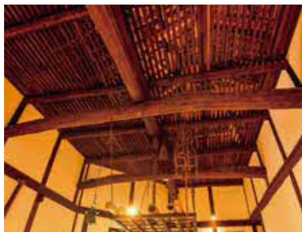
茅葺き屋根を支える小屋組は、日本家屋の魅力の一つ。
