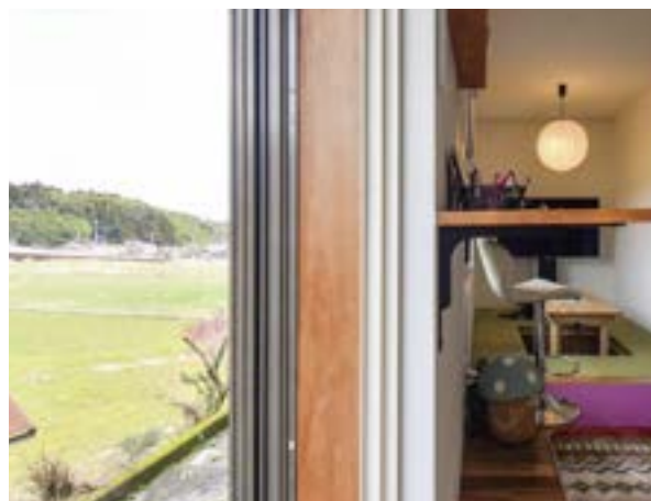
外側から雨戸用の戸袋、既存のサッシ、既存の壁、新設されたサッシと壁。壁もサッシも二重となっている。
