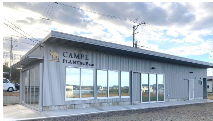
新設した作業場の外観
