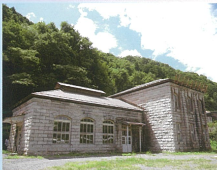
（旧）江尾発電所本館
