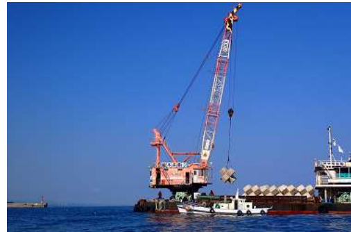
図1 礁の移設状況（泊地区）
