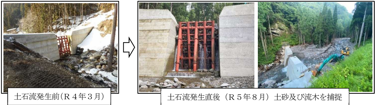
＜図2 砂防堰堤の施設効果事例（令和5年台風第7号 佐治町尾際 北谷川）＞
