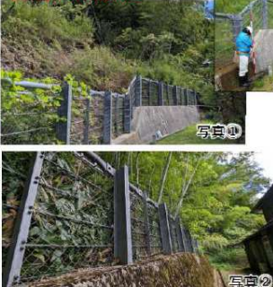
【近景】土砂捕捉状況
