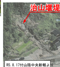
土砂及び流木を捕捉。崩壊防止に効果を発揮した。
